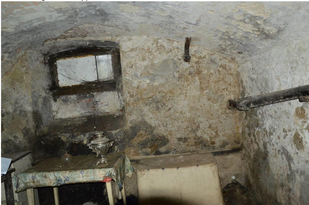
Fot. 8 – Zawilgocone ściany piwnic.
