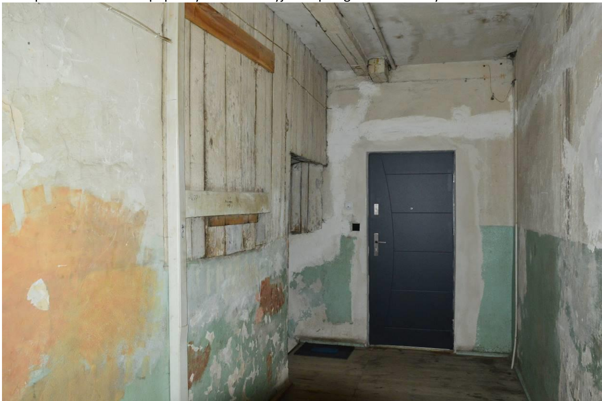
Fot. 5 Korytarz na poziomie poddasza (II piętro) – wymaga natychmiastowego remontu oraz docieplenia ścian w celu poprawy termoizolacyjności przegród budowlanych.
